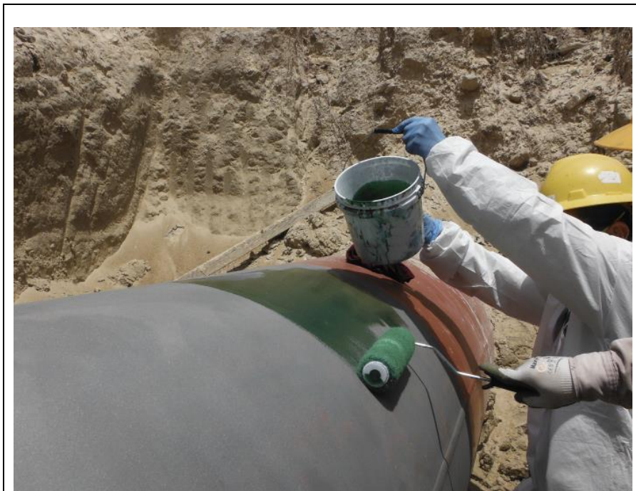
Fig. 6 – Aplicación del Epoxy 314™ en la zona a reparar.
