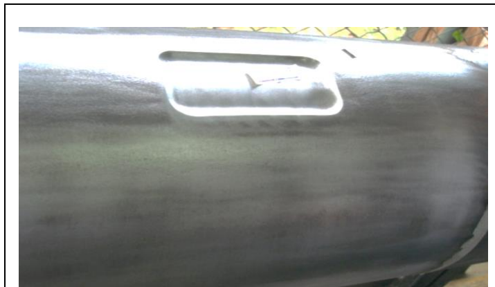
Fig. 3 –El defecto debe ser llenado completamente con masilla de reparación WrapFill 811™ la superficie debe quedar nivelada.
