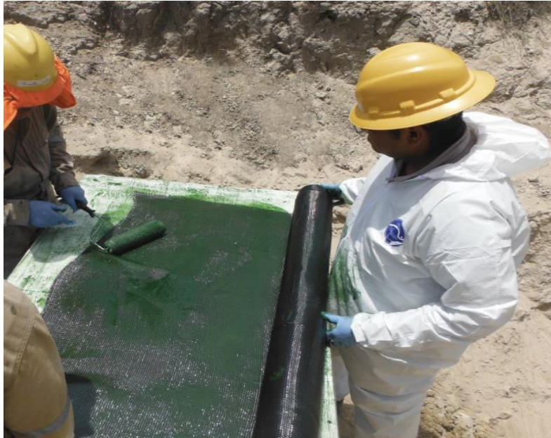
Fig. 7 – Uso de una mesa para impregnación de la fibra Carbon 12K™ con el Epoxy 314™ .
